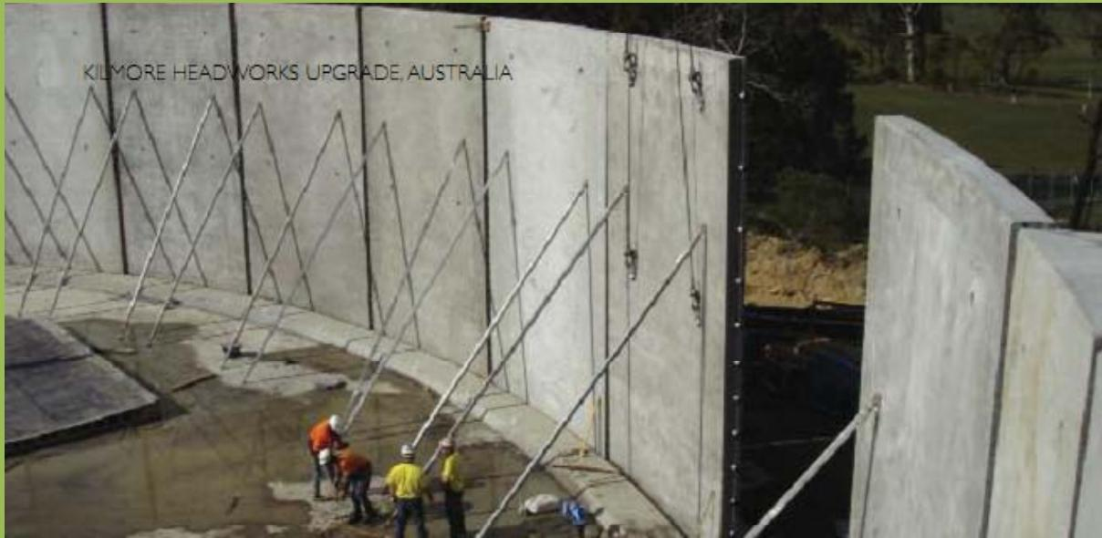
Sistem za naknadno napinjanje BBR VT CONA CMM je certificiran i ima Europsko Tehničko Dopuštenje ETA-06/0165. Horizontalno ugrađeni kabeli u stijenke montažnih elemenata napinju se hidrauličkim prešama na mjestima sidrenih sklopova ugrađenih u dvije lizene. Postupak napinjanja izvodi se pojedinačnim napinjanjem svakog užeta, a prema protokolu napinjanja.
